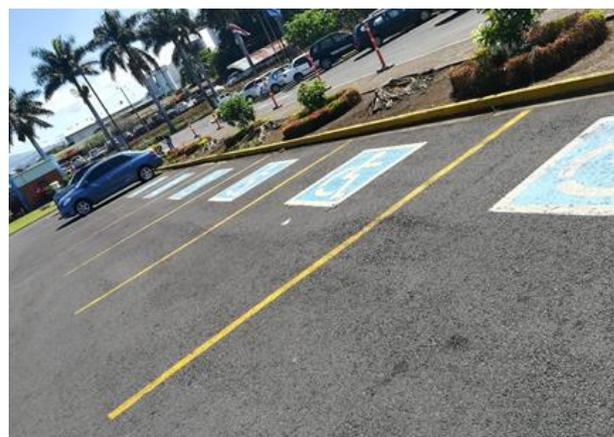
**Imagen 23:** Rotulación Horizontal de Estacionamientos, AC 2
