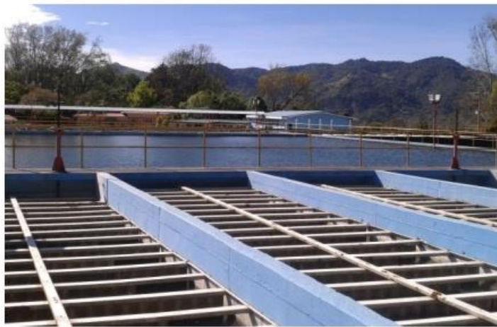
Figura 16. Floculador de pantalla de flujo horizontal
