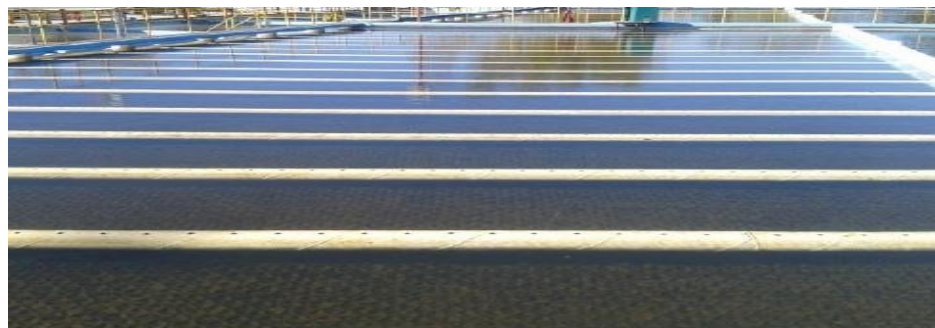
Figura 19. Sedimentador laminar, sección Orosi
