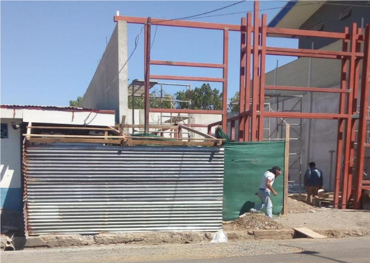
Obra pública. Construcción de la Biblioteca Pública, Esparza Centro.
