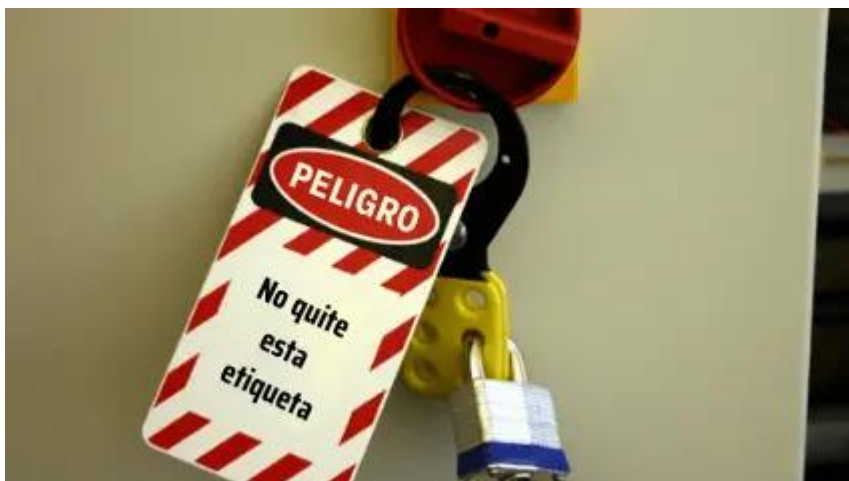
Figura 2 – Colocación dispositivos de bloqueo
