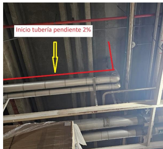
Figura 19 Inicio de tubería de 123m con desnivel del 2%
