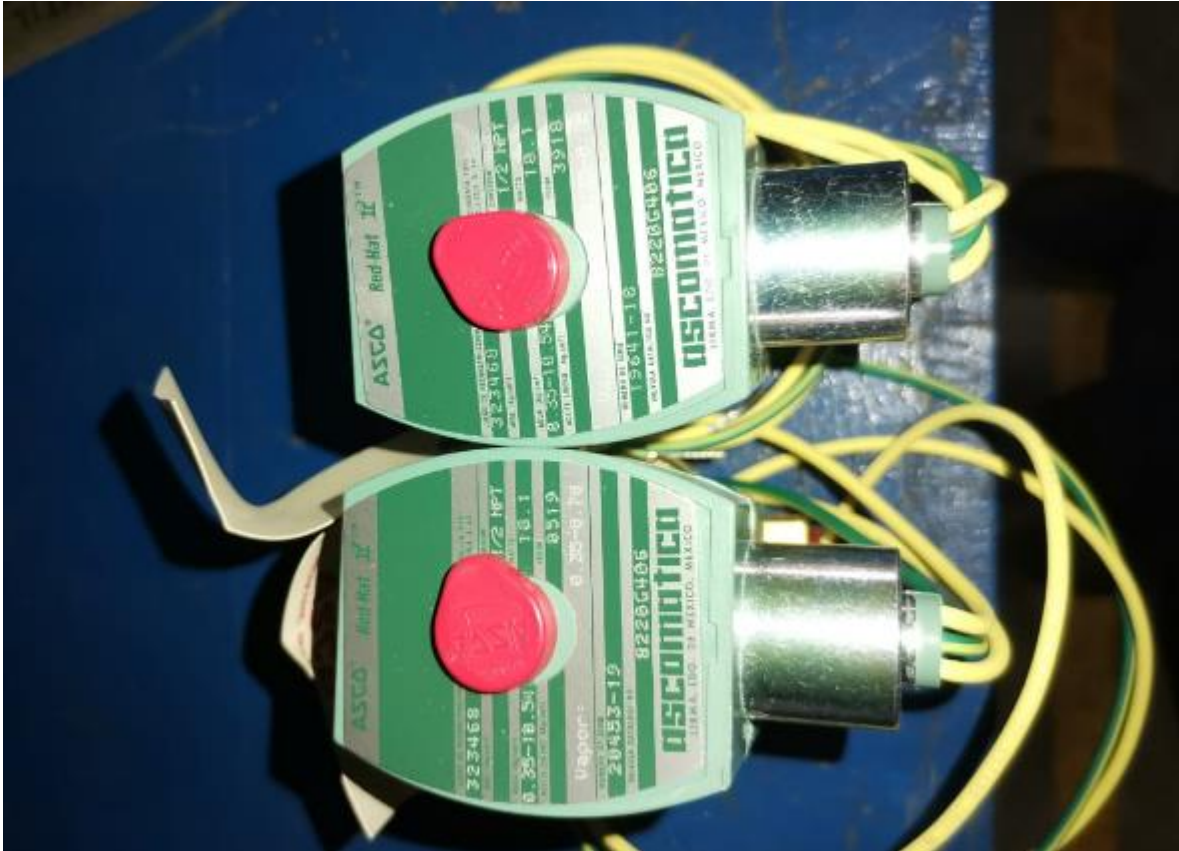
Ilustración 24. Válvulas solenoides de la marca ASCO.
