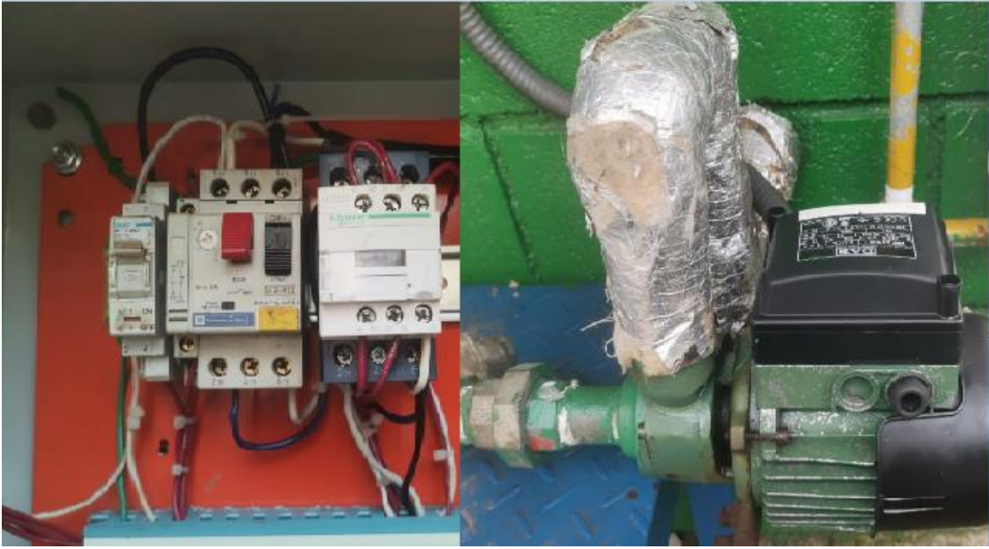
Ilustración 37. Bomba monofásica y su arranque de potencia.
