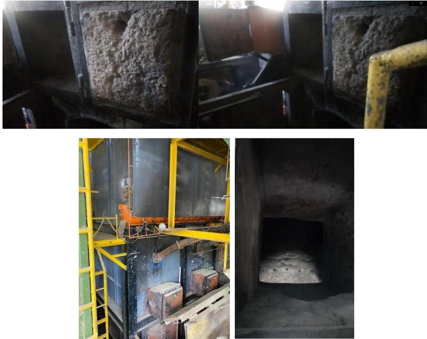
**Ilustración 21. Compartimientos alimentación de madera, Caldera Wickes**
