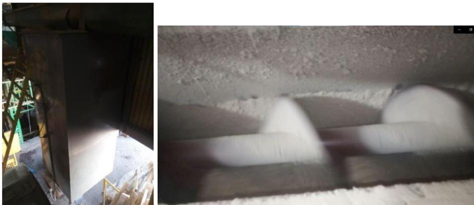
**Ilustración 27. Tolva de almacenamiento de cascarilla y alimentación a caldera, Caldera Lambda**
