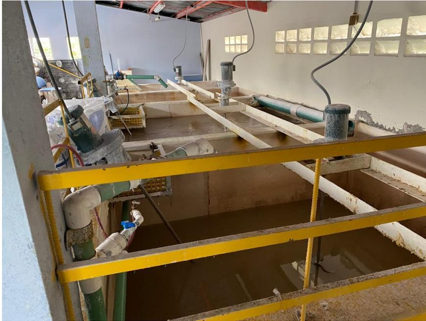
**Ilustración 10.** Bombas agitadoras de sulfato de aluminio
