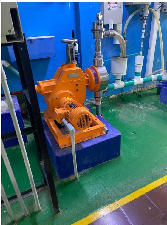
**Ilustración 7.** Bomba dosificadora de sulfato de aluminio
