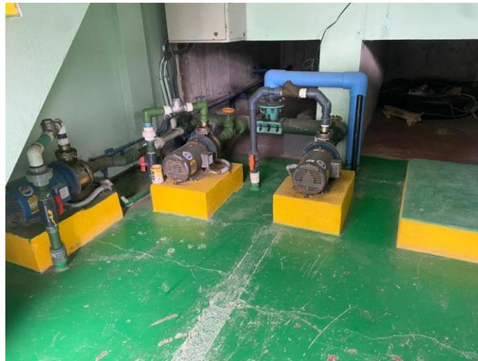
**Ilustración 17. Bombas de cloración**
