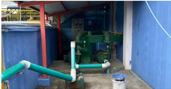
**Ilustración 15.** Bomba de lavado de filtros
