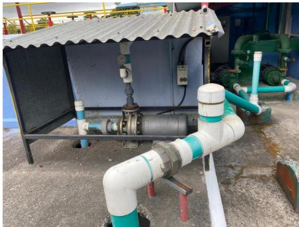
**Ilustración 16.** Bomba de lavado de estructuras
