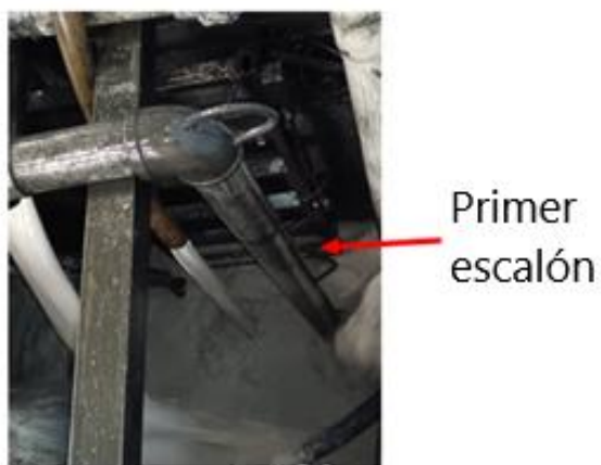
Figura 29. Medición llenada del Tanque
