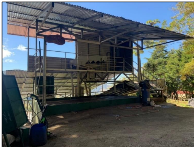
Figura 7 Área de descarga, material desordenado
