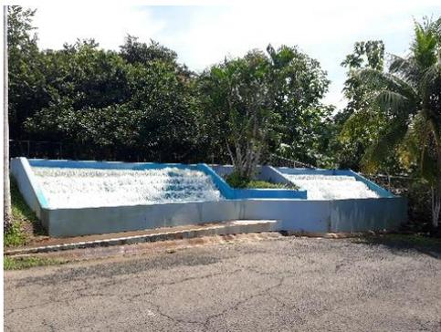
Figura 4: Proceso de aireación.
