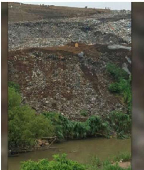
*Figura 3. Colapso de relleno sanitario la Carpio*
