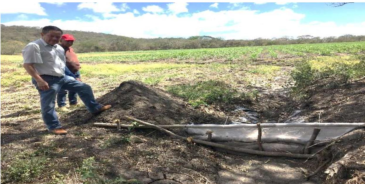
IMAGEN 19. DESPRENDIMIENTO DE TALUD POR EL RIEGO PARCELA 14B
