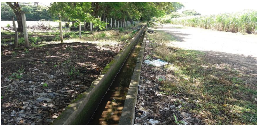
Ilustración 9. Canal rectangular para los lotes UTN L4_L-5 finca UTN sede Guanacaste
