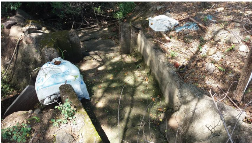
Ilustración 16. Toma del lote L-18 finca UTN sede Guanacaste.
