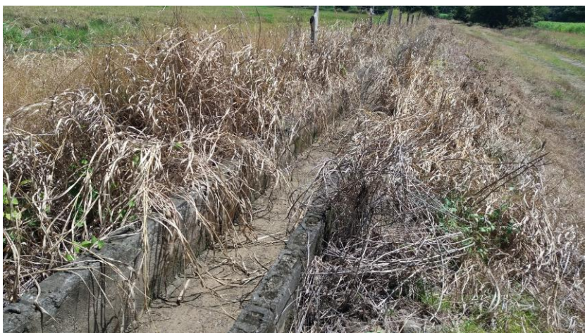
Ilustración 11. Canal principal del lote L-14 finca UTN sede Guanacaste.
